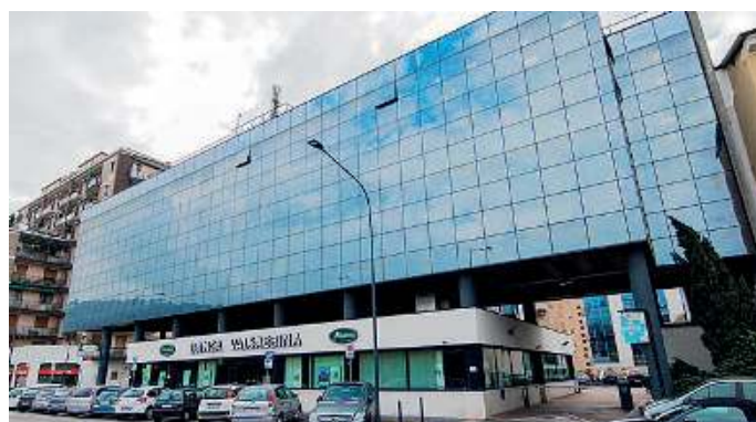
A Brescia. Il quartier generale di Banca Valsabbina
