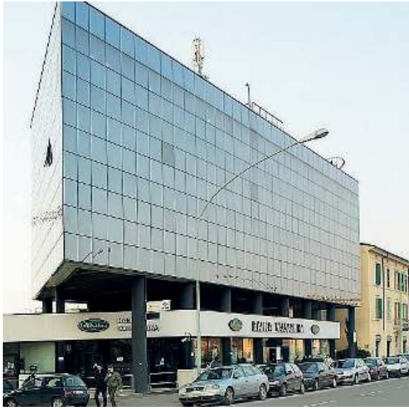
A Brescia. Il quartier generale di Banca Valsabbina
