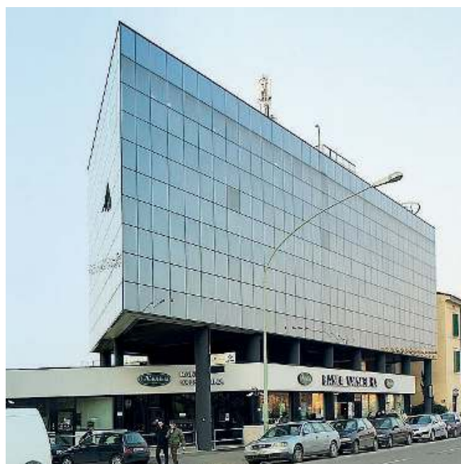
Banca Valsabbina. Il quartier generale a Brescia
